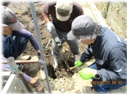
水路補修工事
