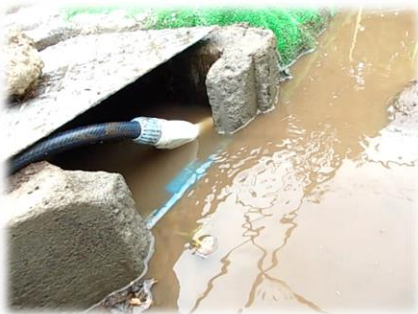
完成した水路
