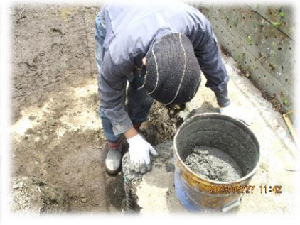
コンクリート外堀補修
